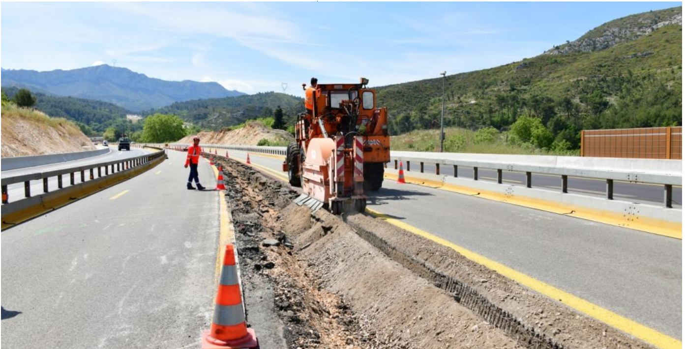
Les glissières métalliques ont été enlevées avant d'être remplacées par des dispositifs en béton qui sépareront les deux sens de circulation (crédit photo : Michel Martini)
