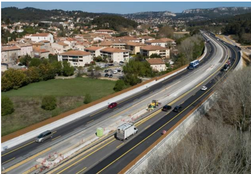
La zone de chantier, entre les deux sens de circulation est en place sur certains secteurs, comme ici au niveau de la commune de La Destrousse (Crédit photo Michel Martini)
