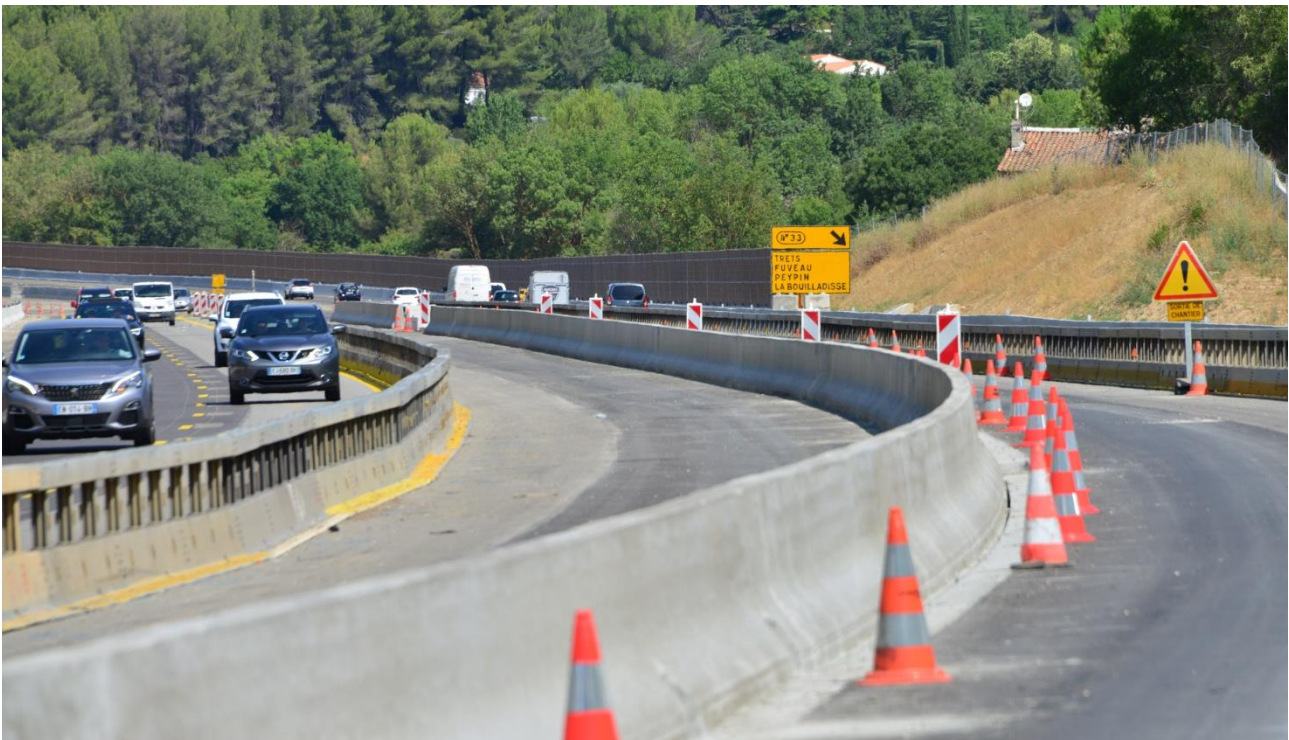
La glissière en béton armée, séparant les deux sens de circulation, est en cours de construction (crédit photos : Michel Martini)
