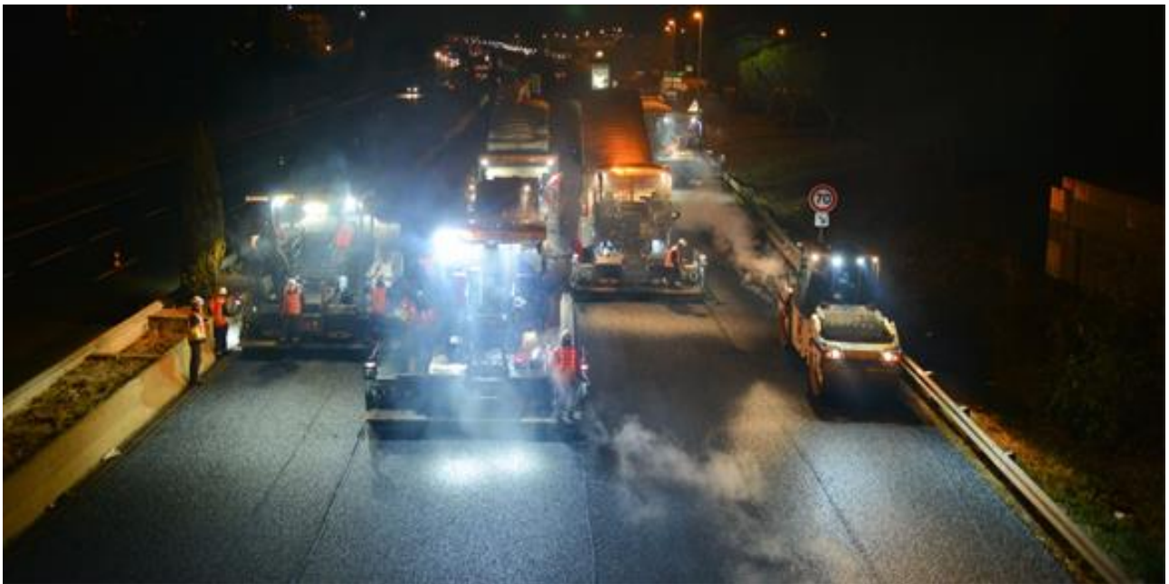
Chantier de chaussée sur l'autoroute A8, de nuit, à Aix-en-Provence.
