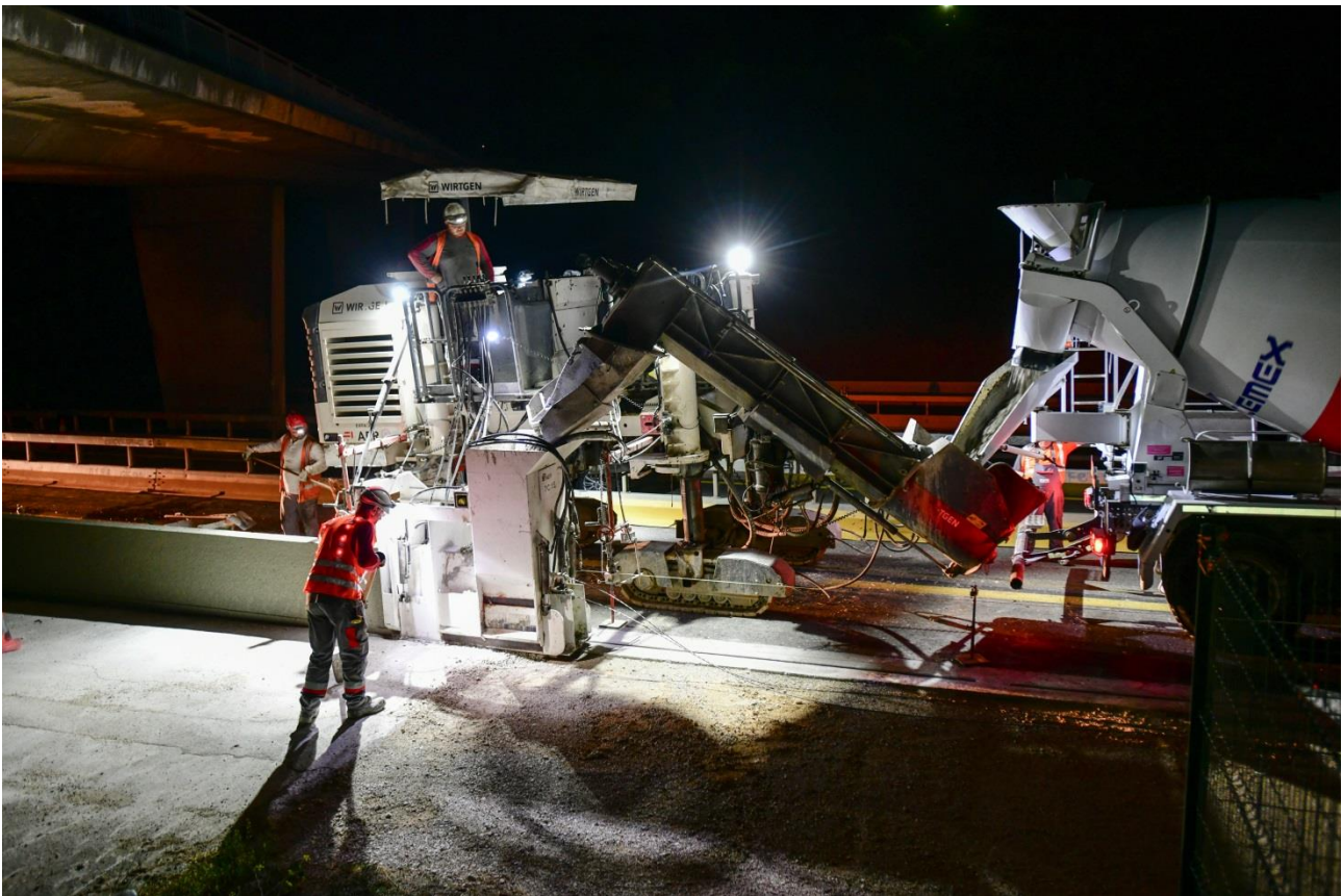
Réalisation de la glissière en béton armé en accotement (crédit photos : Michel Martini)
