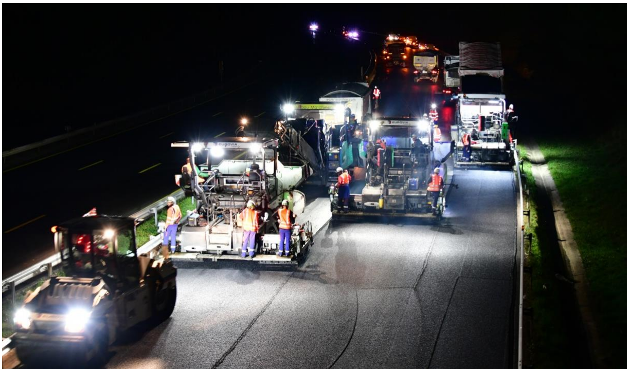
L'atelier « chaussée » comprend trois machines appelées finisseurs qui permettent de mettre en œuvre la nouvelle chaussée sur toute la largeur de l'autoroute A52. (Photo M Martini)
