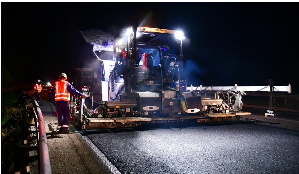
Application du nouvel enrobé sur la chaussée rabotée (Photo : Michel Martini)
